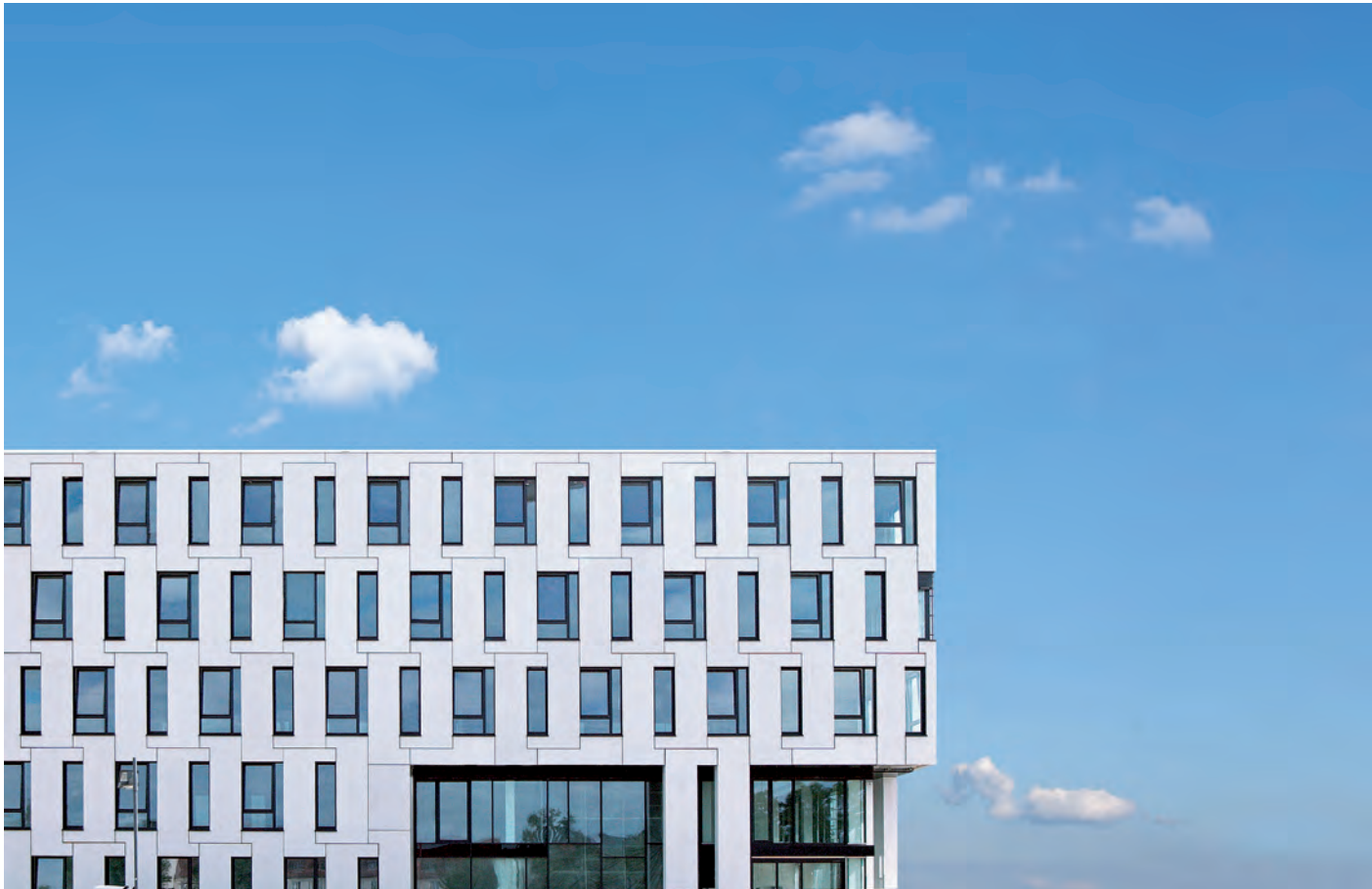
Abb. 1 (Bild oben) Interpretation der Konstruktion als „Haut“. Im Bild sind ornamentartige Elementierungen und grafische Fugenmuster
